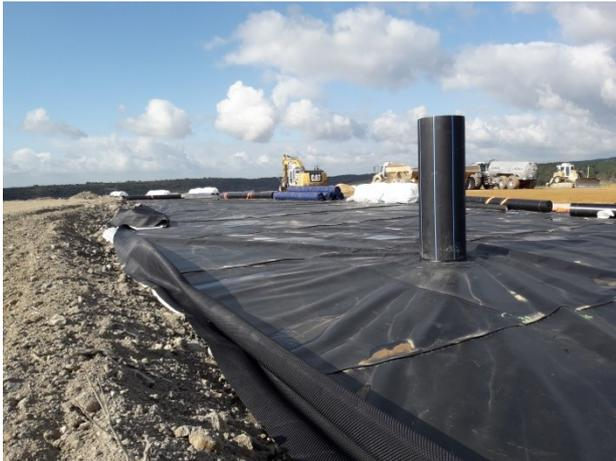
Photo 1 : Puits et raccordement au complexe d'étanchéité (16/03/21)
