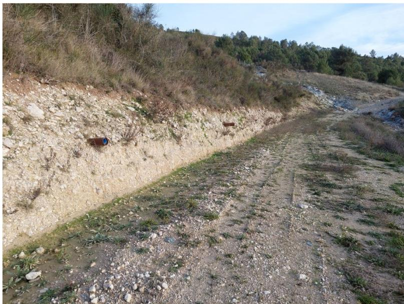
**Photo 18 : Drains sub-horizontaux sur le talus aval du flanc ouest (14/12/21)**
