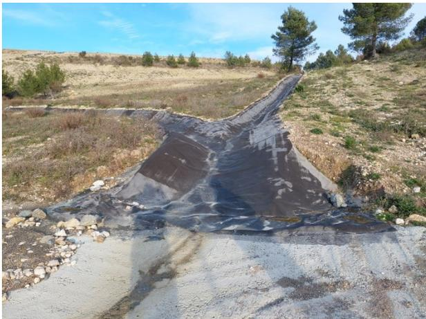
Photo 10 : Descente d'eau avec membrane bitumineuse flanc Ouest (20/12/21)
