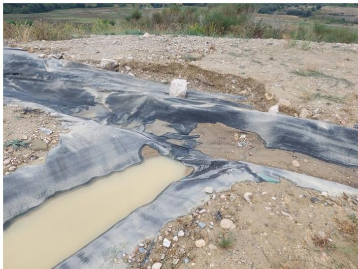
Photo 26 : Erosion en bordure de géomembrane (09/09/21)
