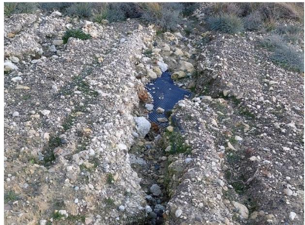
Photo 22 : Erosion jusqu'à l'accroche terre (14/12/21)
