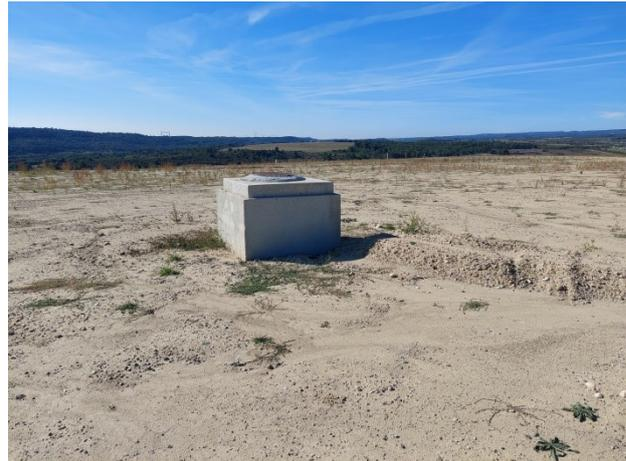
Photo 2 : Puits protégé par un regard bétonné (13/10/21)
