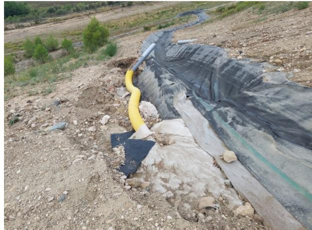
**Photo 13 : Déchaussement d'un drain - Flanc ouest
